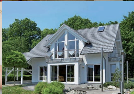
EINFAMILIENHAUS Frischlufte für die ganze Familie
